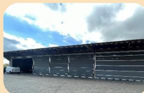
Le bâtiment engrais-céréale a été agencé avec 6 cases dans la largeur et des rideaux souples permettant le stockage d'environ 1100 T de marchandises en vrac.
